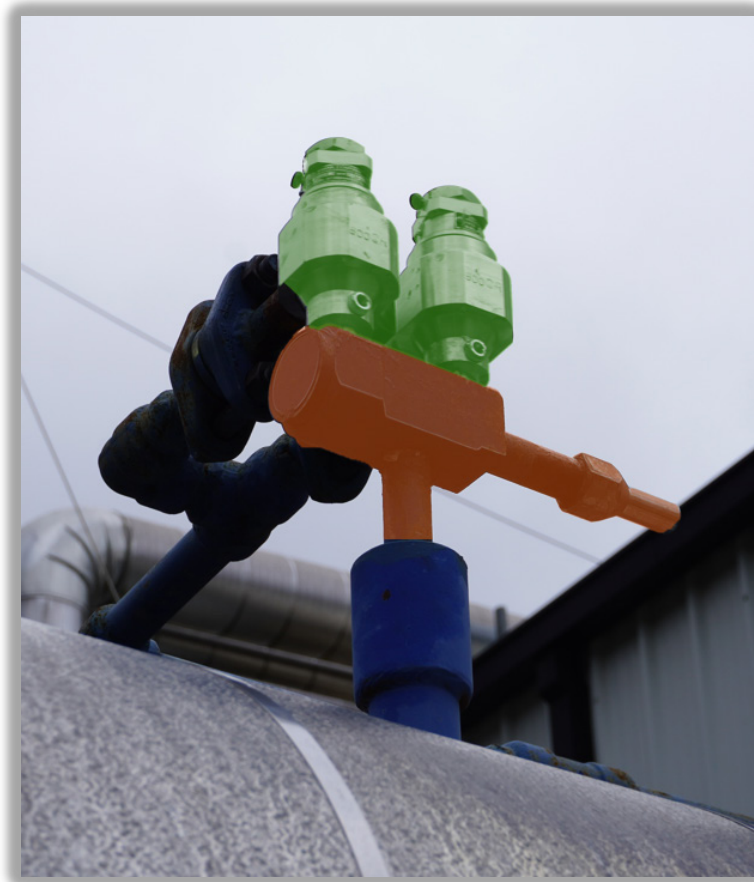
Figura 6: Conjunto de VAPE para un tambor de compensación en el Tank Park 5, que incluye dos válvulas de alivio de presión de emergencia (verde) y la válvula selectora de tres vías (naranja). (Crédito: CSB)
