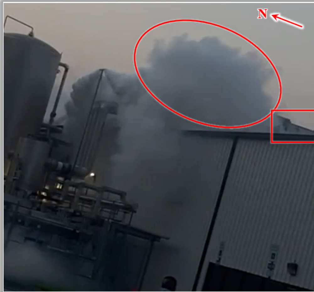
Figura 23: Gran parte del amoníaco liberado cayó al suelo (parte inferior izquierda), pero parte permaneció en el aire sobre el tejado del edificio (óvalo rojo). Obsérvese la unidad de climatización en la nube visible (recuadro rojo). (Crédito: Empleados de Cuisine Solutions, con anotaciones de la CSB).
