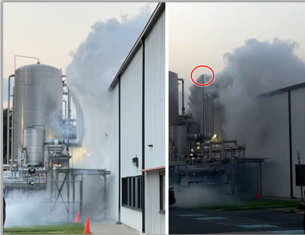
Figura 11: Nube de amoníaco visible durante la liberación (izquierda) y el punto de liberación (marcado con un círculo, derecha) a través de un difusor horizontal en forma de T. (Crédito: Empleados de Cuisine Solutions, anotado por CSB)
