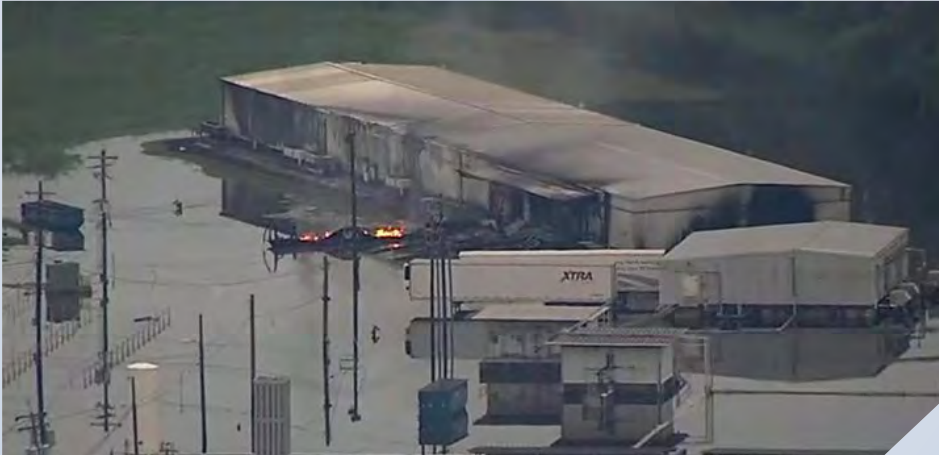
Almacén después de explosión.
